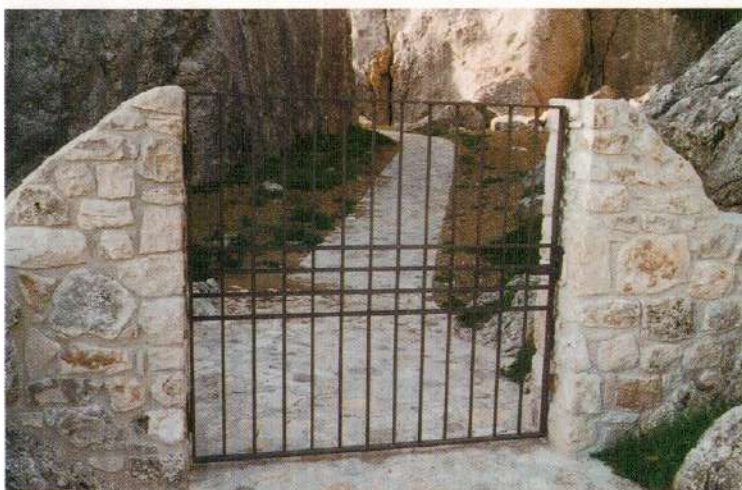
Realizzazione stradina di accesso a Grotta S. Angelo. foto 10
