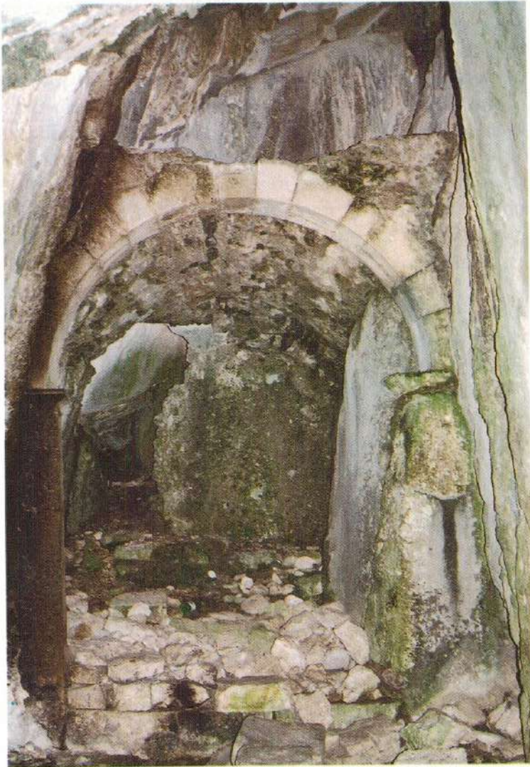
Grotta S. Angelo, arco che precede l'abside (stato di fatto). -foto 2-
